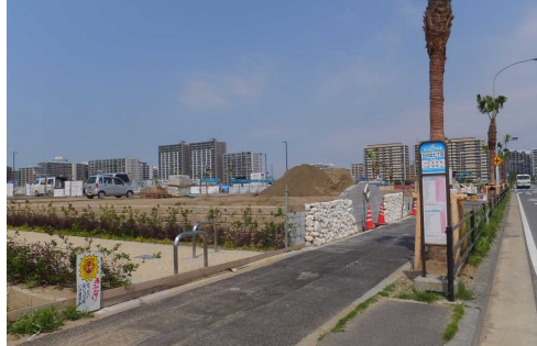
日の出7・建売り住宅の基礎工事を始める(5月23日)
